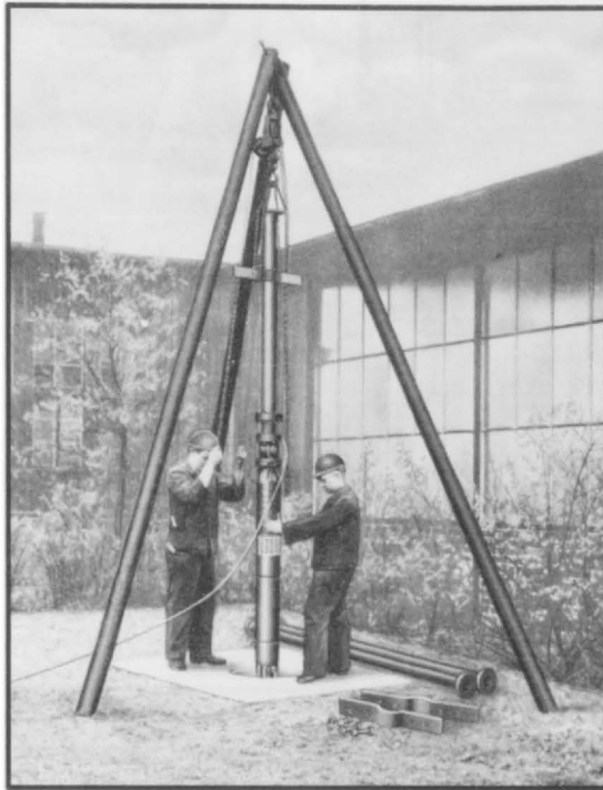
شکل ۱۷- روش نصب الکتروپمپ شناور
