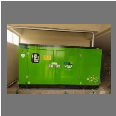
10 KVA KOEL Diesel Generator
