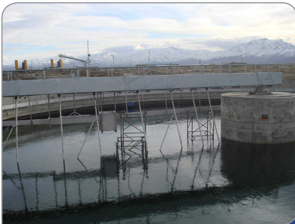
پل های دوار ساخته شده توسط شرکت فامکو
